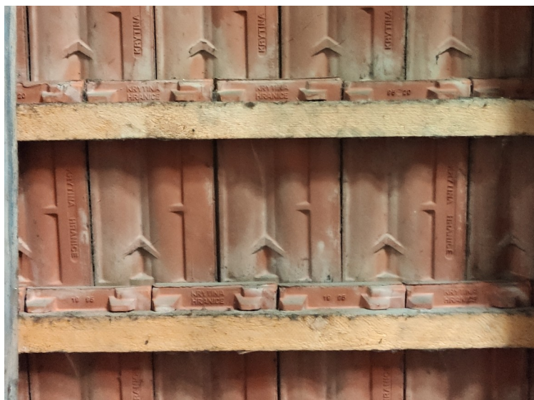
Zdj.6. Widok ogólny łąt i pokrycia
