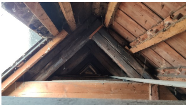
Zdj.15. Wzmocnienie połączenia kalenicowego krokwi grzędą.
