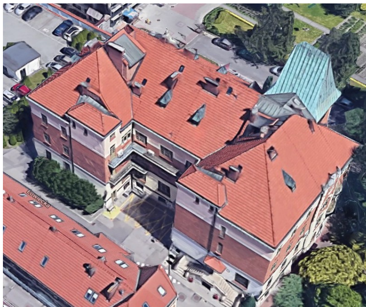
Zdj.2. Widok elewacji południowo-zachodniej budynku
