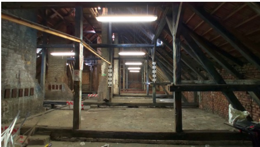
Zdj. 12. Widok ogólny więzarów pełnych z zastrzałami i kleszczami usztywniającymi
