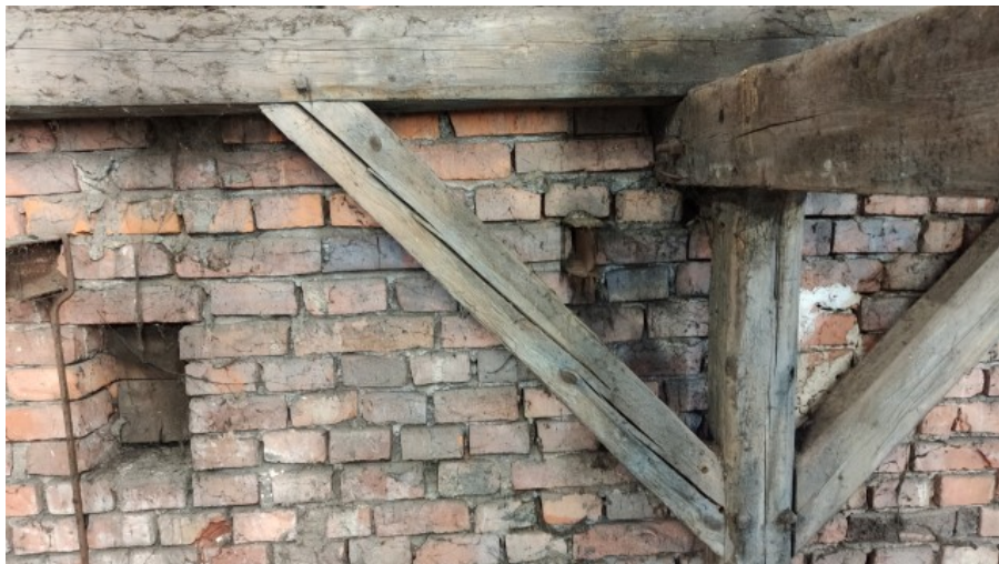
Zdj.10. Miecze dwustronne wraz z połączeniami na czopy blokowane drewnianymi kołkami.
