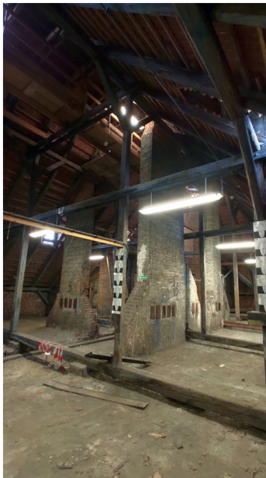
Zdj.5. Widok ogólny konstrukcji poddasza
