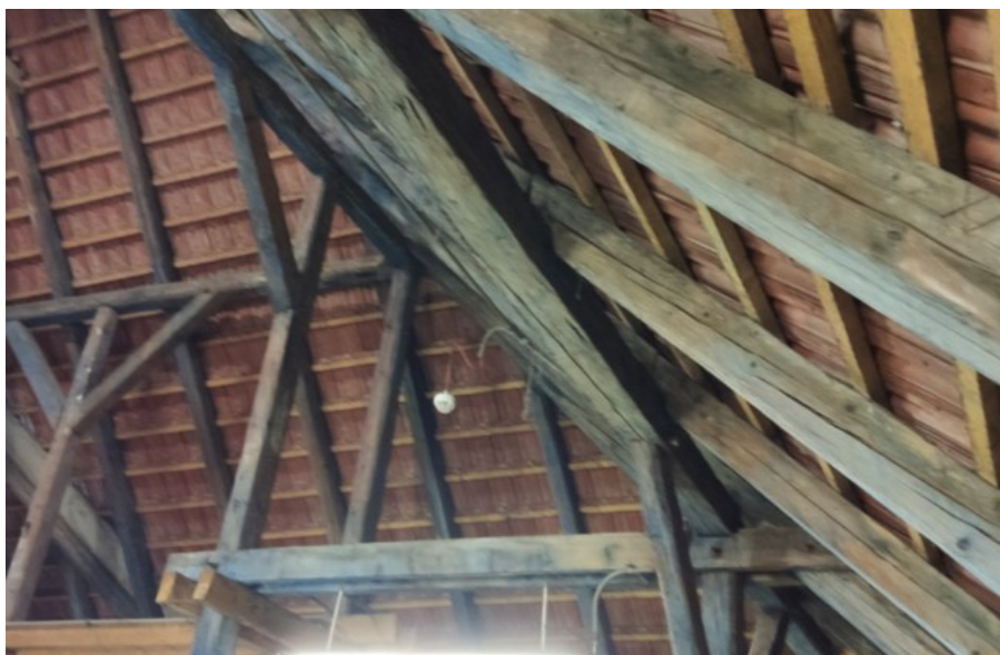
Zdj.7. Składanie krokwi na poziomie niższych ścian stolcowych
