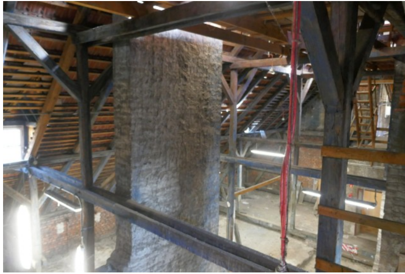
Zdj.4. Widok ogólny konstrukcji poddasza oraz pomostów roboczych
