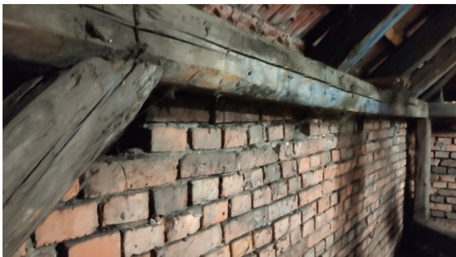
Zdj.9. Widok płatwi okapowej przy ścianie kolankowej
