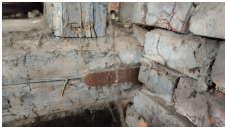
Zdj.14. Tramy oparto w kieszeniach w murze i uchwycono stalowymi klamrami.
