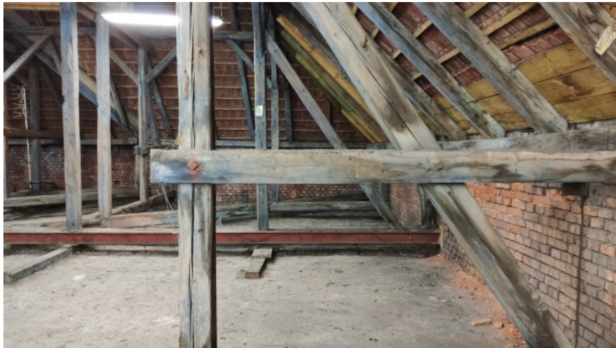
Zdj.13. Widok na kleszcze usztywniające
