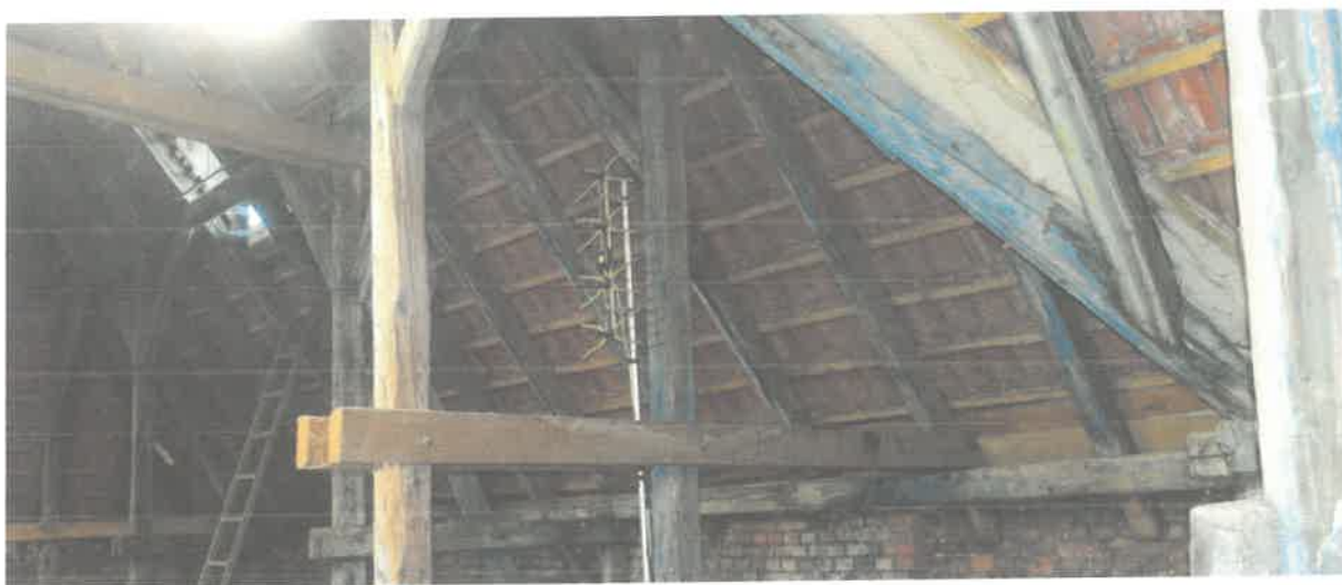
Fot. Nr 9. Poddasze. Więźba i połać dachowa nie noszą śladów zasiedlenia przez gatunki chronione.
