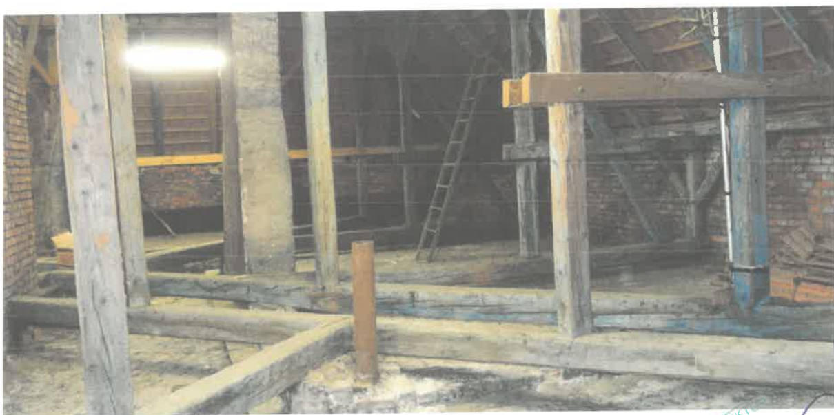
Fot. Nr 10. Poddasze. Więźba dachowa i powierzchnia stropu nie noszą śladów zasiedlenia przez gatunki chronione.
