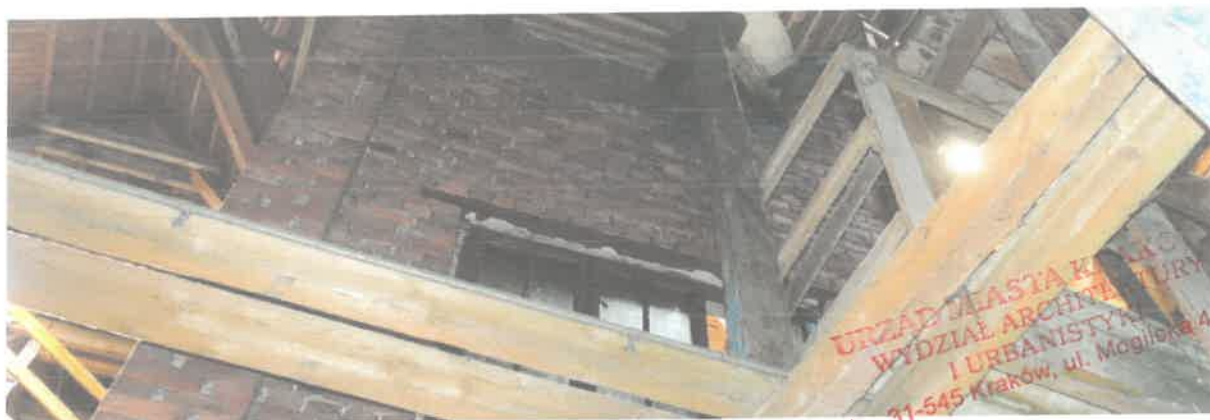
Fot. Nr 8. Poddasze. Więźba i połać dachowa nie noszą śladów zasiedlenia przez gatunki chronione.
