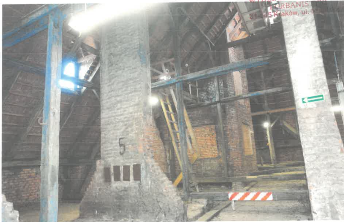
Fot. Nr 17. Poddasze. Więźba i połać dachowa nie noszą śladów zasiedlenia przez gatunki chronione.
