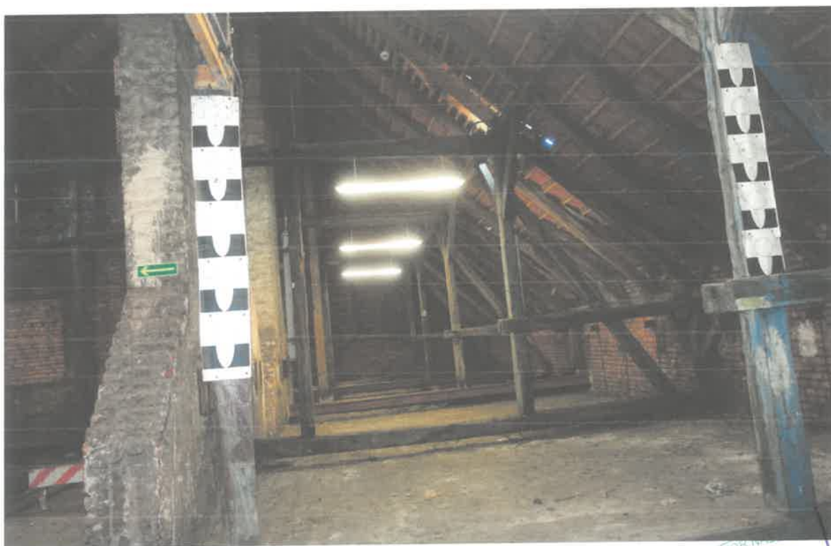
Fot. Nr 18. Poddasze. Więźba, połać dachowa jak również powierzchnia stropu nie noszą śladów zasiedlenia przez gatunki chronione.
