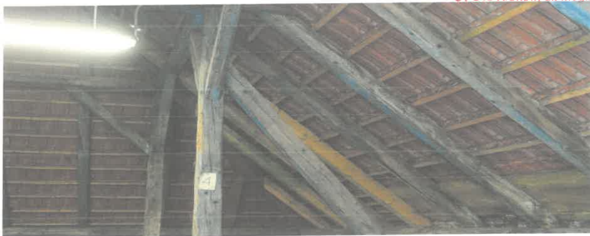
Fot. Nr 11. Poddasze. Więźba i połać dachowa nie noszą śladów zasiedlenia przez gatunki chronione.
