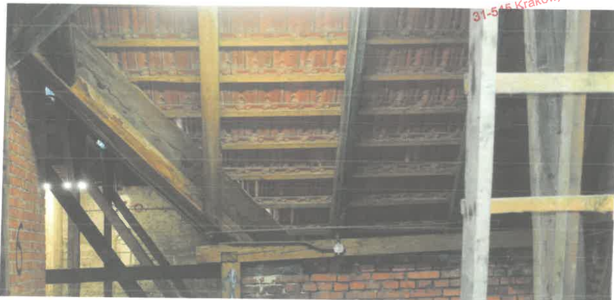
Fot. Nr 5. Poddasze. Więźba i połać dachowa nie noszą śladów zasiedlenia przez gatunki chronione.
