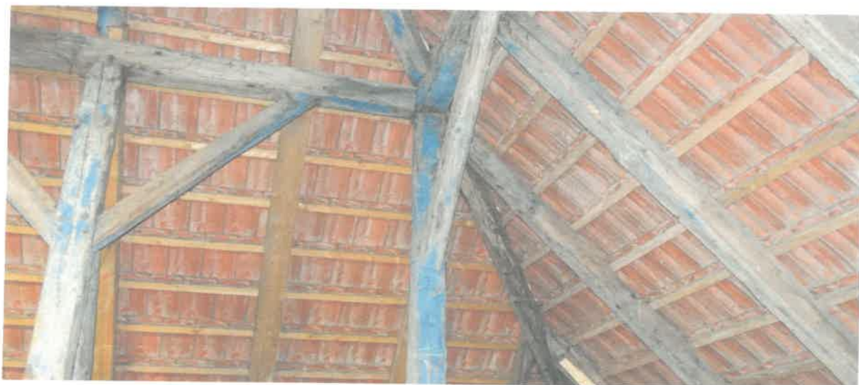
Fot. Nr 6. Poddasze. Więźba i połać dachowa nie noszą śladów zasiedlenia przez gatunki chronione.
