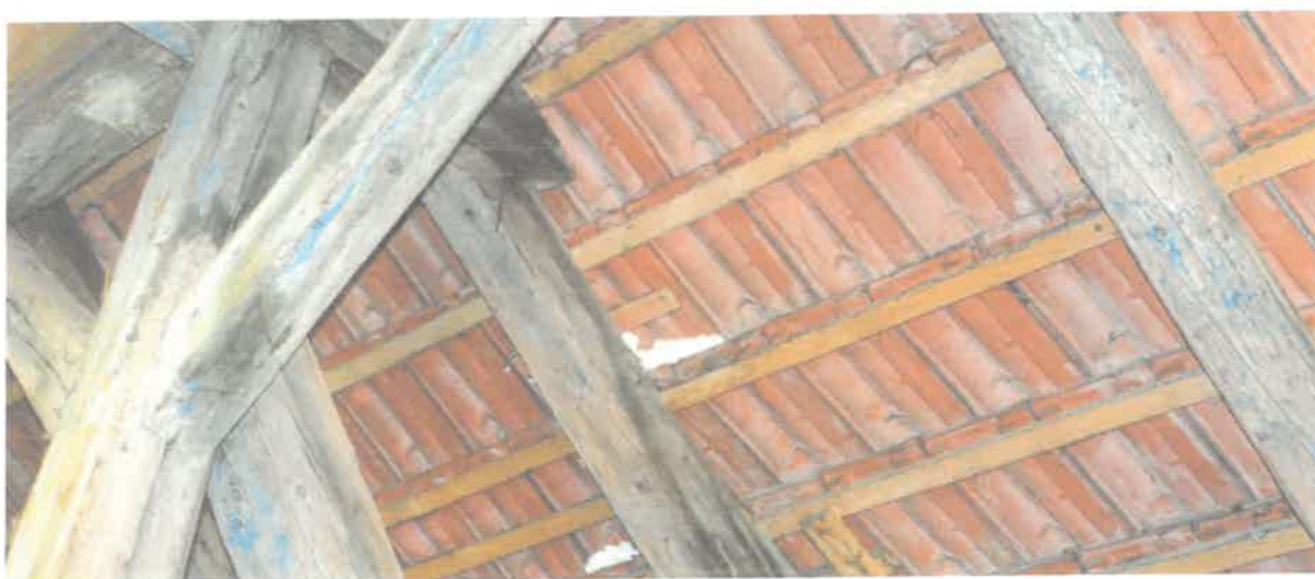
Fot. Nr 12. Poddasze. Więźba i połać dachowa nie noszą śladów zasiedlenia przez gatunki chronione.
