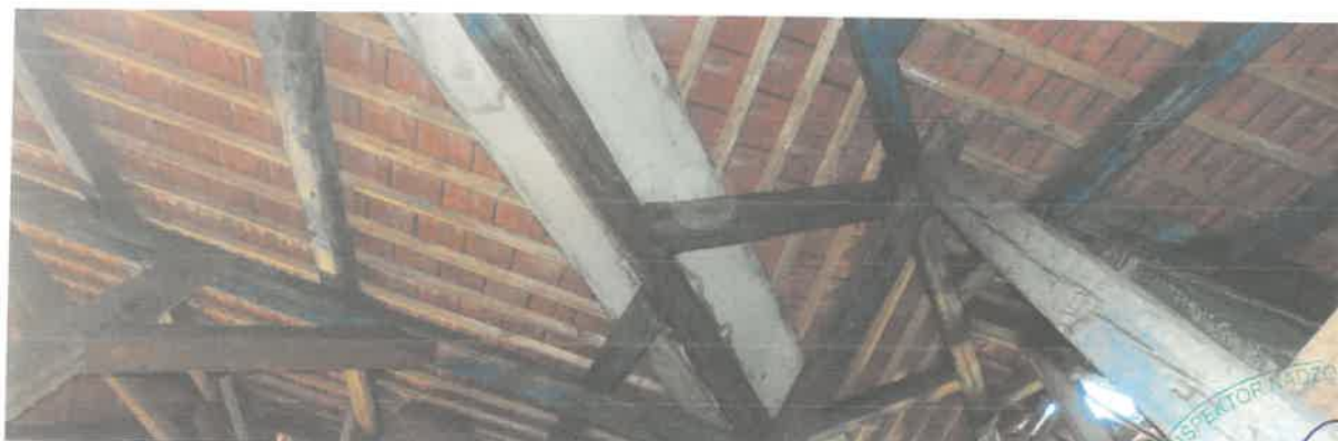
Fot. Nr 7. Poddasze. Więźba i połać dachowa nie noszą śladów zasiedlenia przez gatunki chronione.
