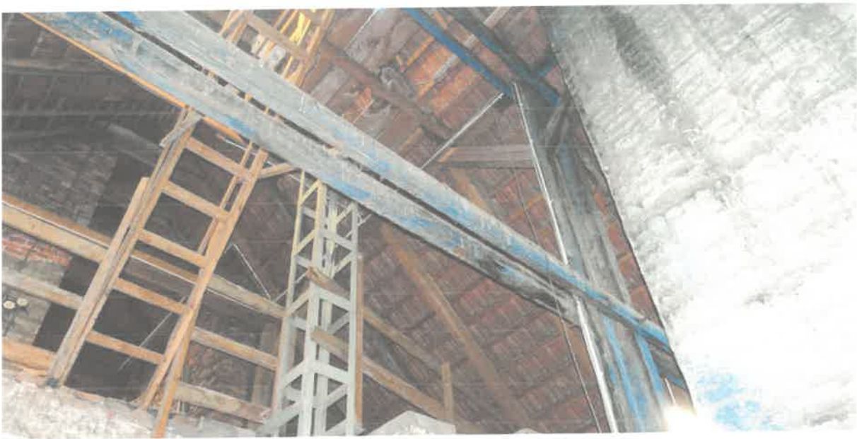
Fot. Nr 15. Poddasze. Więźba i połać dachowa nie noszą śladów zasiedlenia przez gatunki chronione.
