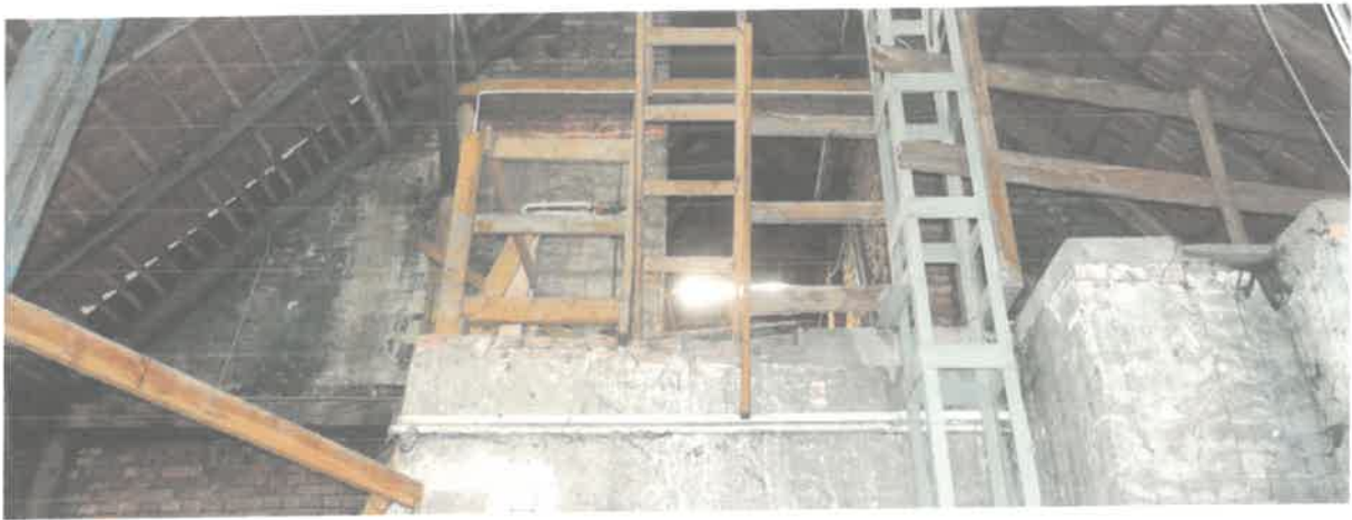
Fot. Nr 14. Poddasze. Więźba i połać dachowa nie noszą śladów zasiedlenia przez gatunki chronione.
