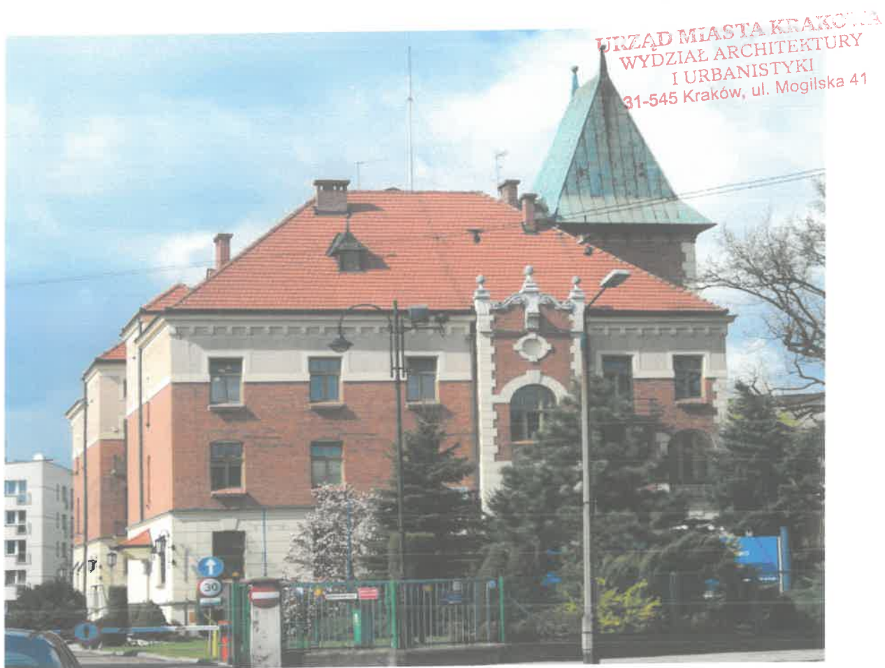
Fot. Nr 2. Widok budynku Wodociągów Krakowskich od strony ul. Senatorskiej w Krakowie.
