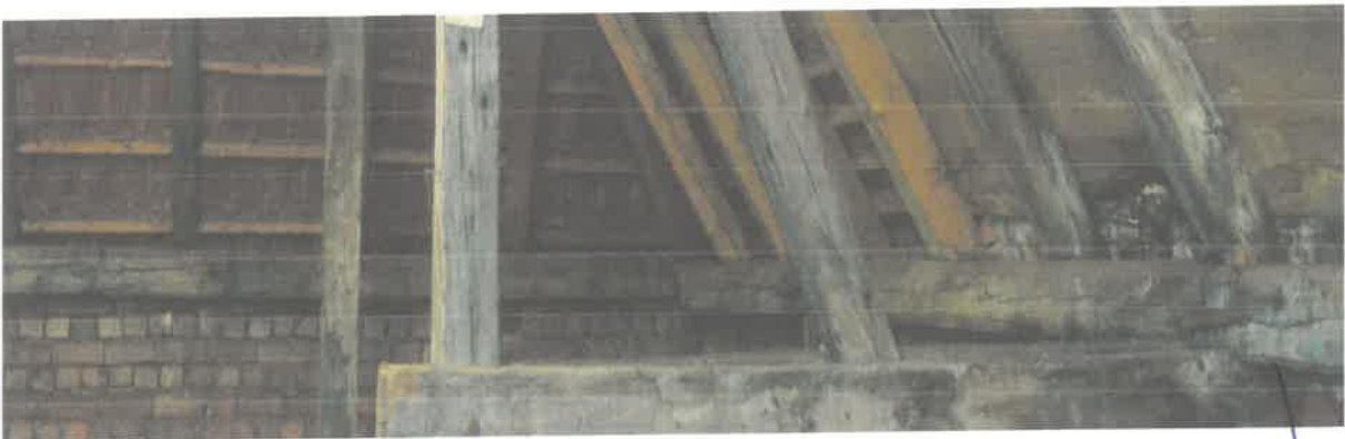
Fot. Nr 16. Poddasze. Więźba i połać dachowa nie noszą śladów zasiedlenia przez gatunki chronione.
