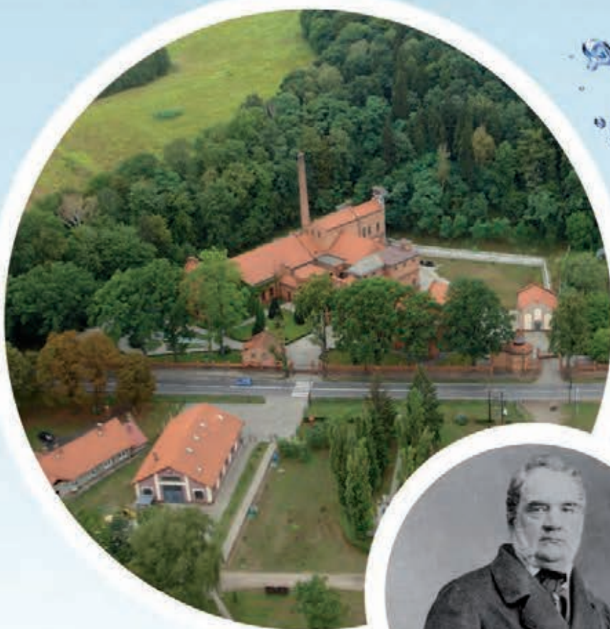
Zakład Uzdatniania Wody „Bielany” Uruchomiony 14 lutego 1901 roku
