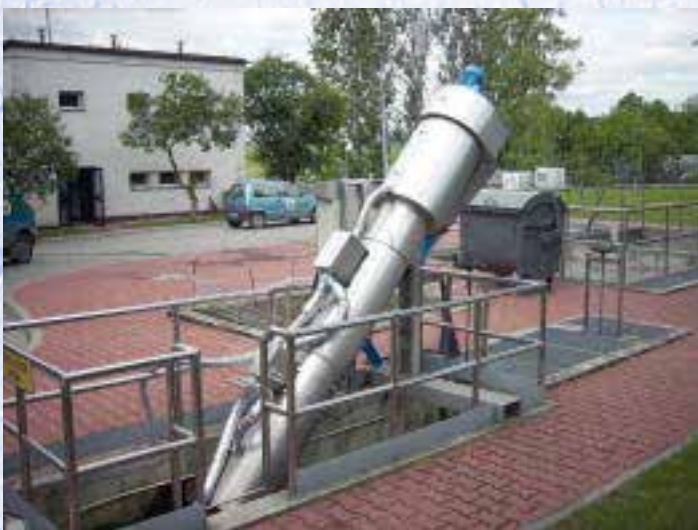
Oczyszczalnia Bielany sito typu Ro9
