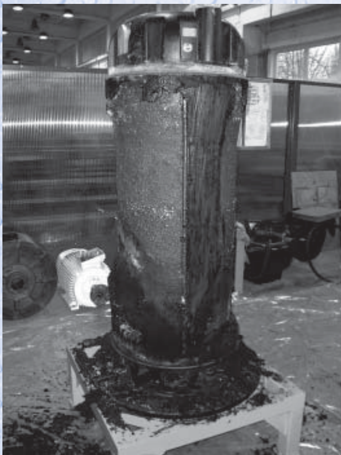
Pompa w trakcie demontażu
