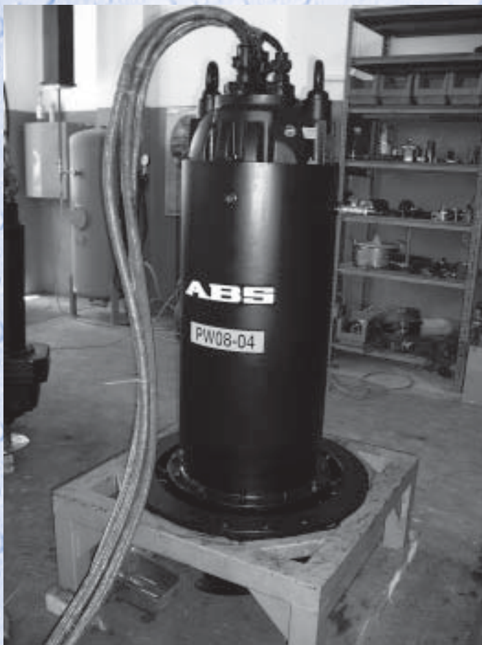
Pompa po wykonanym remoncie
