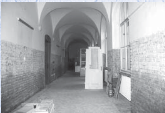
Powódź dokonała wielkich zniszczeń
