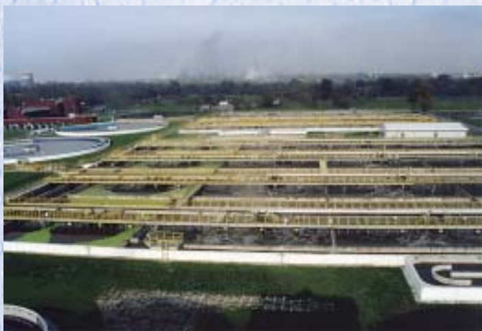
Komory osadu czynnego
