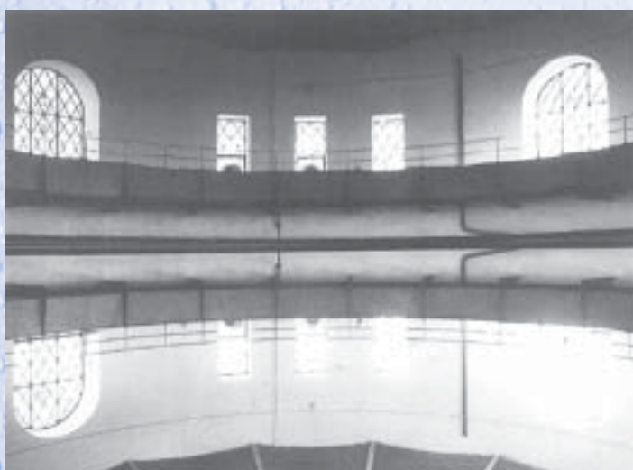
Poziom wody w wieży ciśnień, przy wypełnionym zbiorniku
