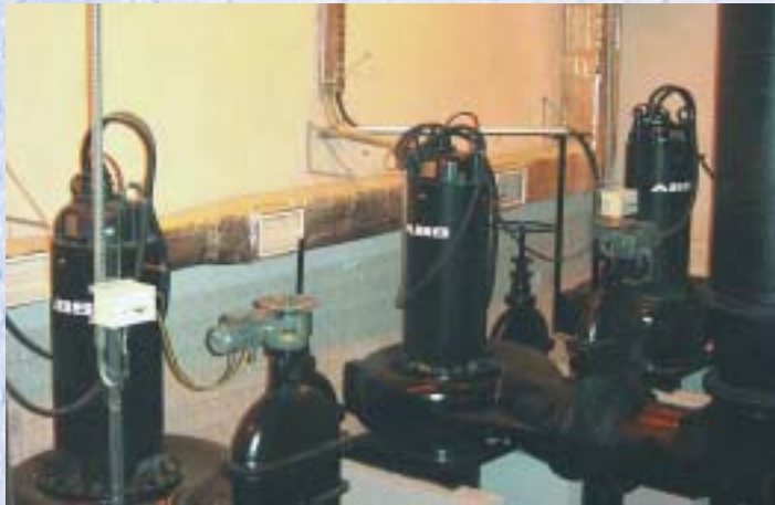
Wnętrze pompowni głównej z nowym wyposażeniem
