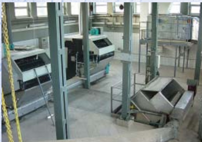
Wnętrze budynku krat z nowym wyposażeniem
