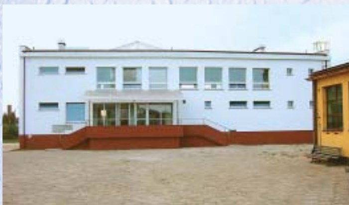
Budynek przyszłej dyspozytorni (dawny magazyn) widok z zewnątrz
