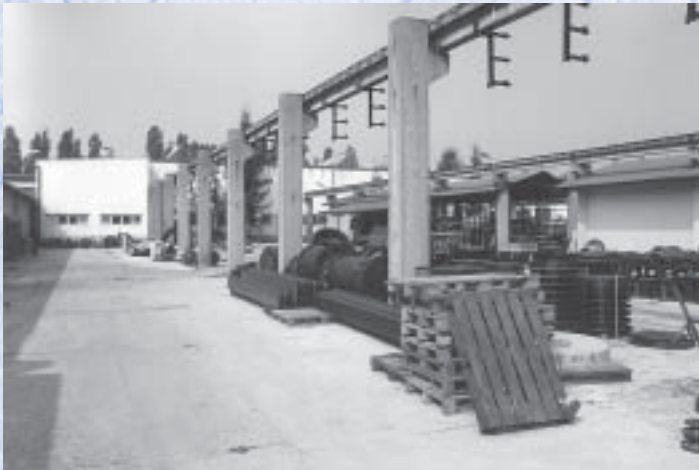
Plac składowy, oraz pozostałości konstrukcji suwnic dźwigowych
