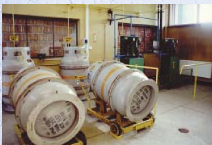
Zdj. 2. Dotychczasowe urządzenia do chlorowania wody. Na pierwszym planie beczki z chlorem, w głębi stare chloratory C7
