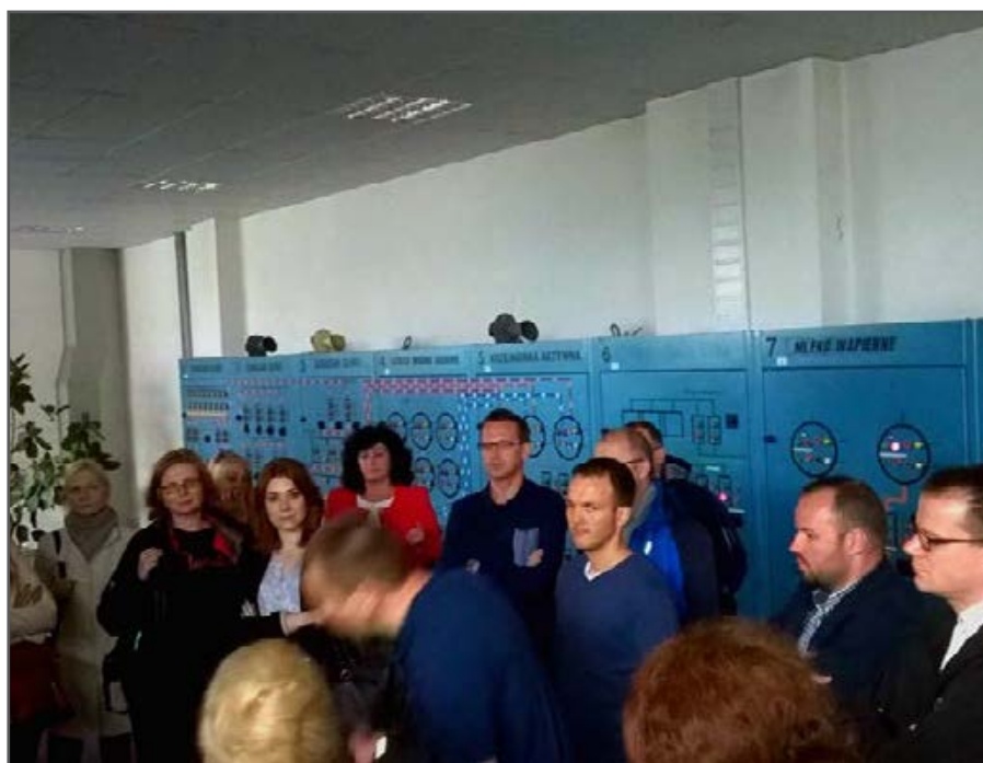
Fot. 5. Dyżurka budynku chemicznego
