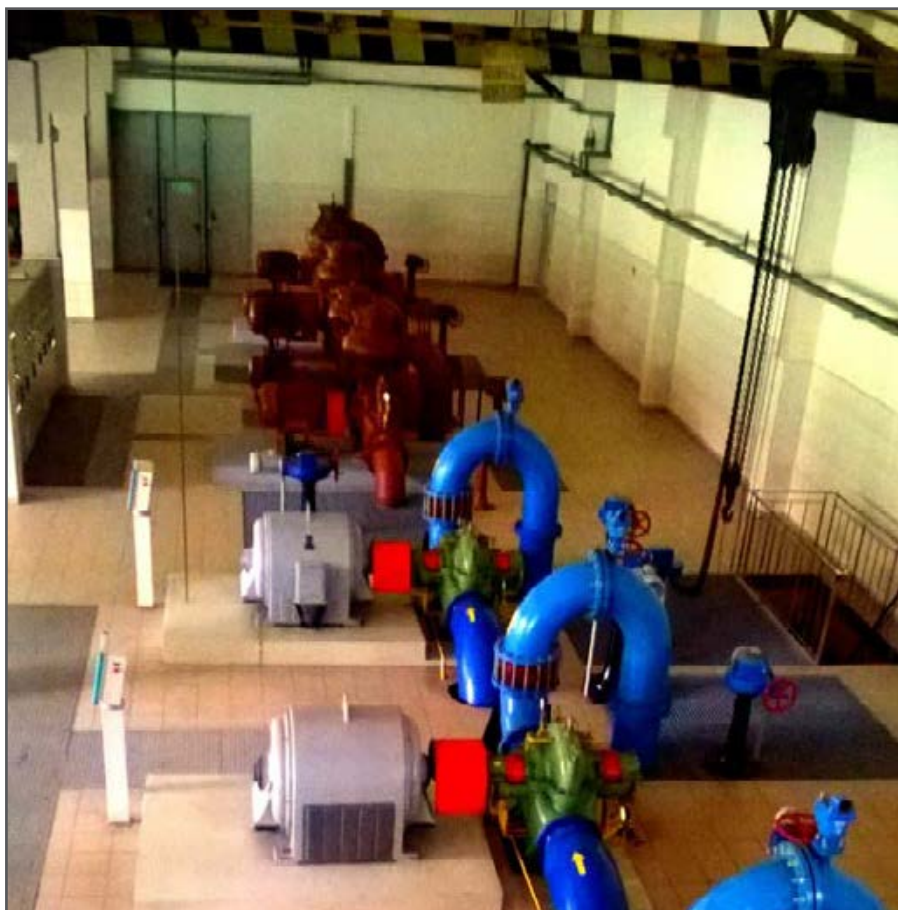
Fot. 4. Pompownia wody czystej Raba I. W kolorze niebieskim- rurociągi ssawne i tłoczne wody czystej wraz z pompami (w kolorze zielonym); w kolorze brązowym- pompy i rurociągi wód płucznych wykorzystywanych do płukania filtrów.
