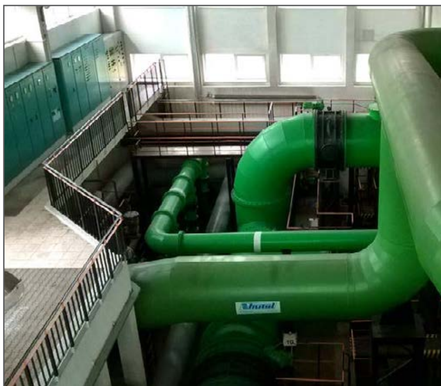
Fot. 3. Rurociągi odprowadzające wodę ze zbiornika kontaktowego do komory rozdziału oraz przelewowe
