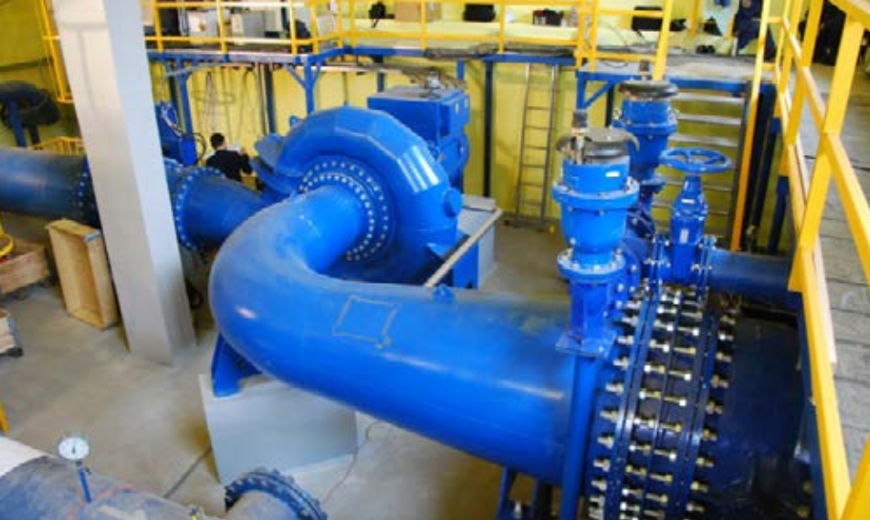
Rys 4. Widok turbiny w trakcie prac montażowych w komorze KP3
