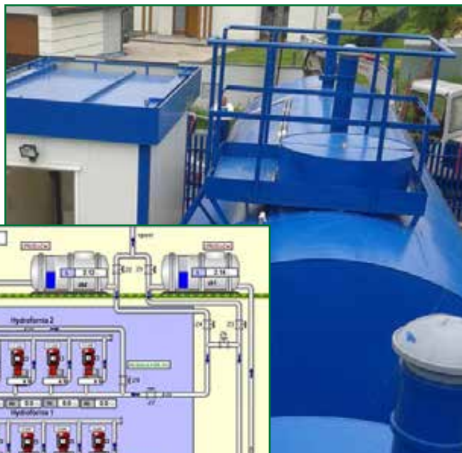
Część naziemna hydroforni
