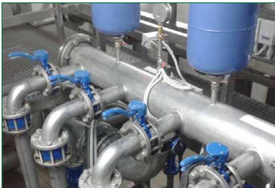
Zestaw hydroforowy HS1 w komorze podziemnej
