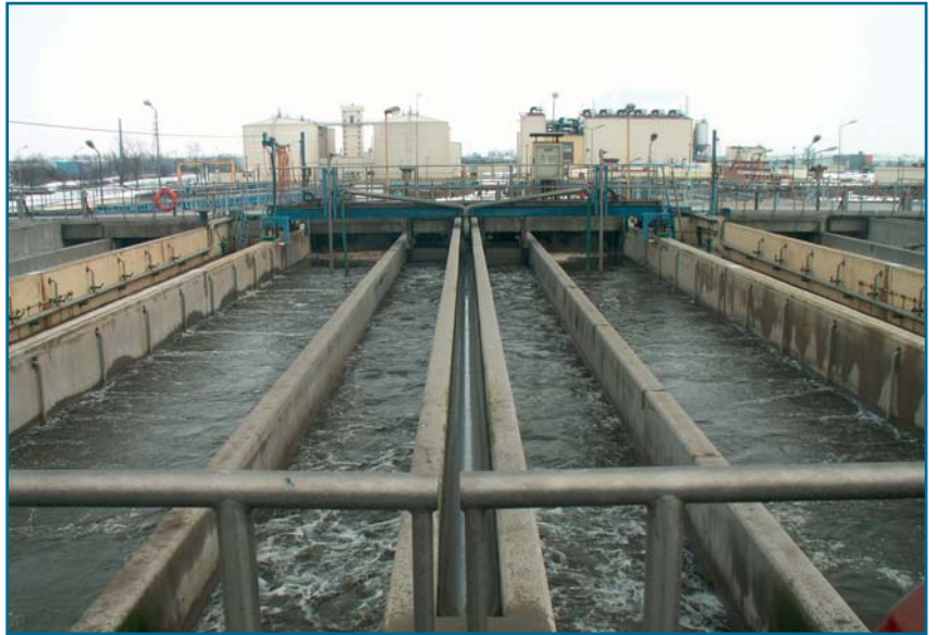
○ Rys 4. Piaskownik poziomy napowietrzany - oczyszczalnia ścieków Płaszów.
