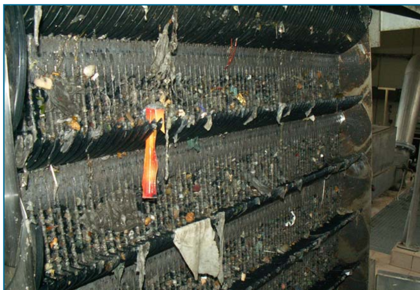
○ Rys 2. Krata gęsta hakowa w oczyszczalni ścieków Płazów.
