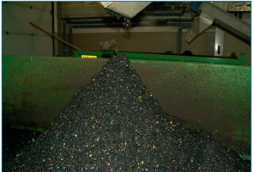
○ Rys 5. Zawartość piaskowników - oczyszczalnia ścieków Płaszów
