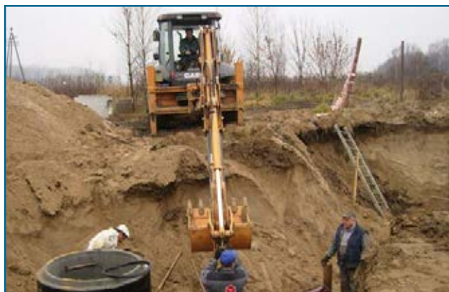
Budowa osadnika Imhoffa i Reaktora biologicznego
