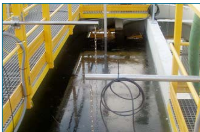
Reaktor biologiczny w trakcie rozruchu technologicznego
