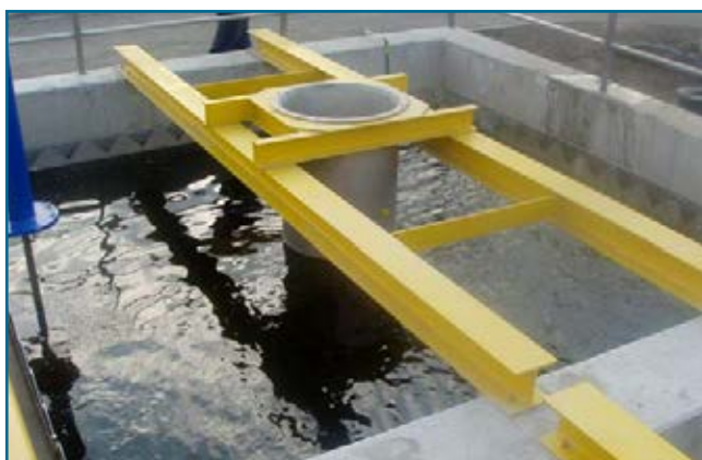
Pracujący osadnik wtórny
