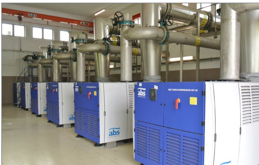
III etap - Budynek Stacji Dmuchaw
