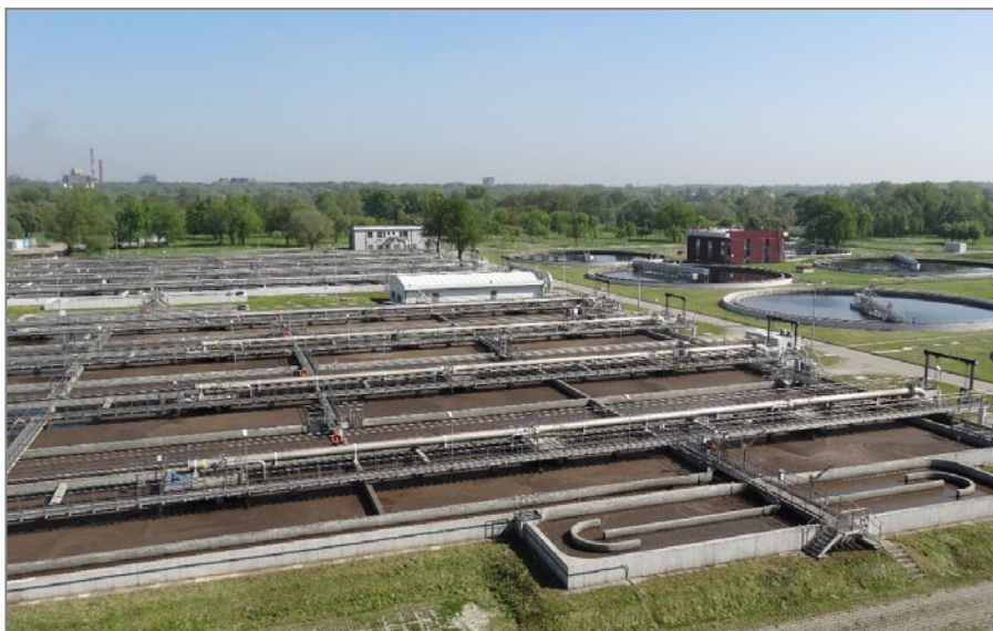
III etap - Reaktory Biologiczne (KOCZE) nowym systemem napowietrzania
