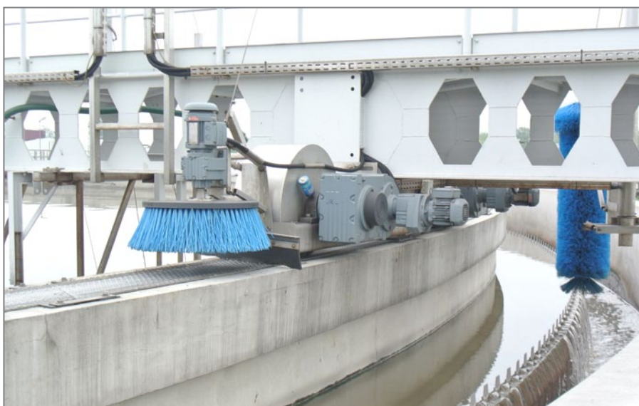
III etap - zmodernizowany Osadnik Wstępny z wbudowanym ogrzewaniem bieźni
