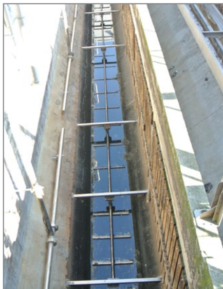
Po modernizacji - zgarniacz piku w Separatorze Zanieczyszczeń Grubych (piaskownik)
