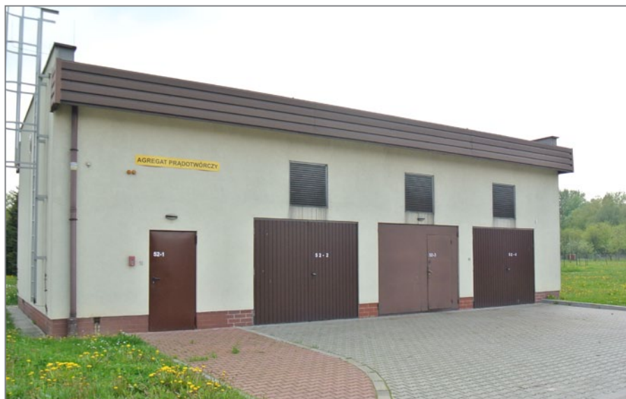
II etap - Budynek Generatorów
