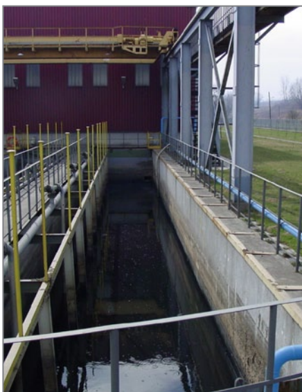
Przed modernizacją - Separator Zanieczyszczeń Grubych z działającą suwnicą.
