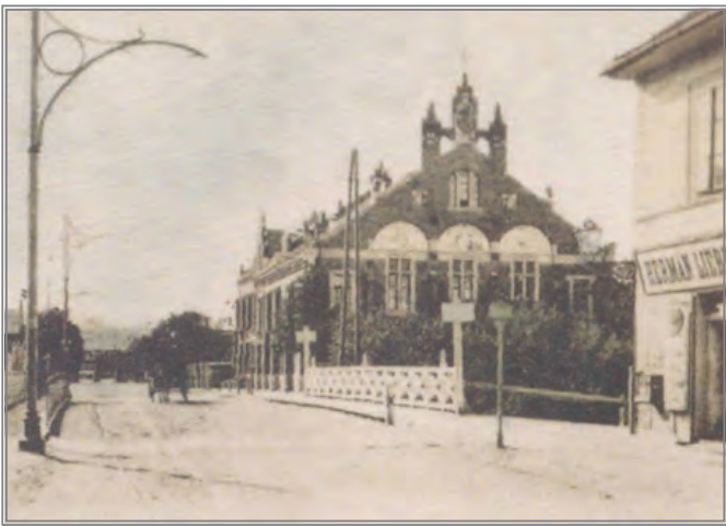
Rysunek 11. - Most Wolski (znany również jako Spalony) wzdłuż ulicy Wolskiej około 1903. Za mostem na prawo widoczny jest budynek Towarzystwa Gimnastycznego "Sokół". (Źródło: https://upadektechnikirakowa.blogspot.com/2017/03/mosty-krakowa-cz4-mae-mosty.html )
