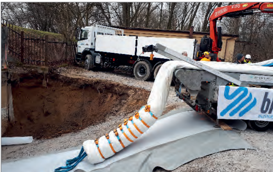
Rys. 5. Przygotowania do instalacji rękawa
