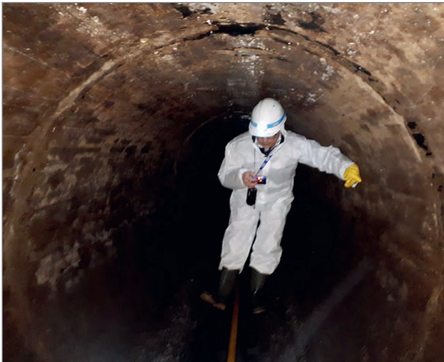
Rys. 3. Wnętrze syfonu po czyszczeniu
