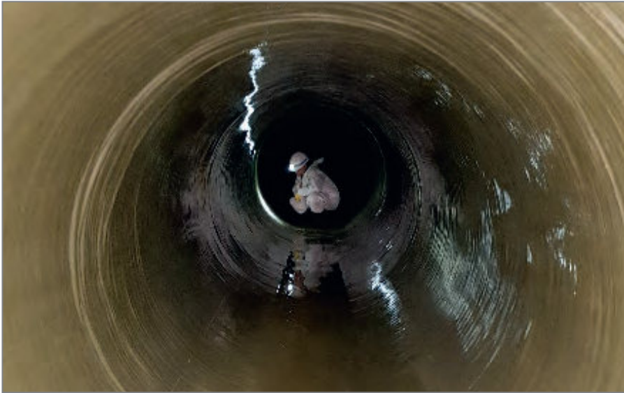
Rys. 4. Wnętrze syfonu po instalacji rękawa
