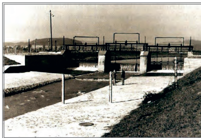
Rysunek 16. - Jaz i ujęcie wody na Rudawie w Mydlnikach. (Źródło: https://upadektechnikikrakowa.blogspot.com/2018/06/wodociagi-krakowa-cz3.html za książką "Wodociagi Krakowa")
