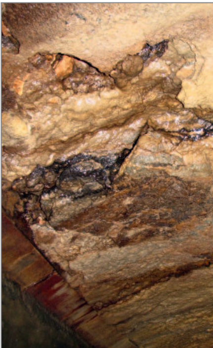
Rys 3. Korozja siarczanowa w kolektorze ogólnospławnym
