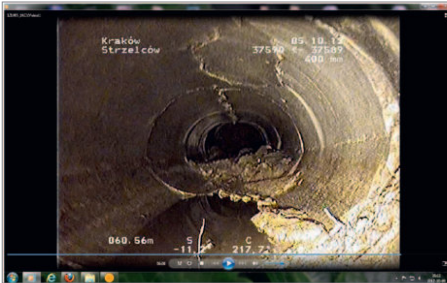
Rys. 2 Mechaniczne uszkodzenie kanału betonowego.
