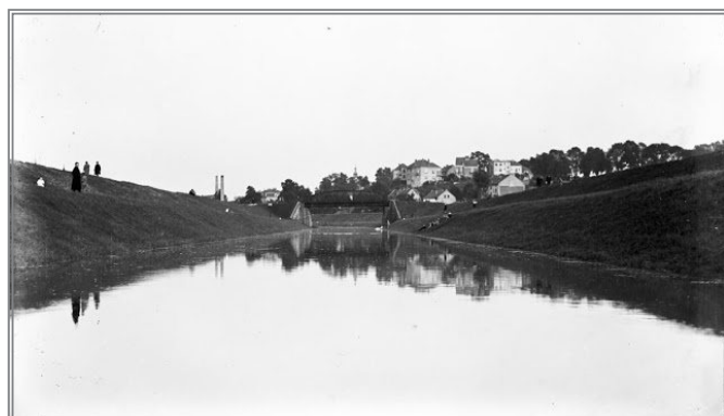
Rysunek 7. - Nowe koryto Rudawy otoczone wysokim wałem przeciwpowodziowym. Na zdjęciu z 1926 widoczny most żelazny w alei Focha, a w głębi zabudowania dzielnicy Salwator (Źródło: https://upadektechnikrakowa.blogspot.com/2017/04/mosty-krakowa-cz5-zagrozenie-powodziowe/ )
