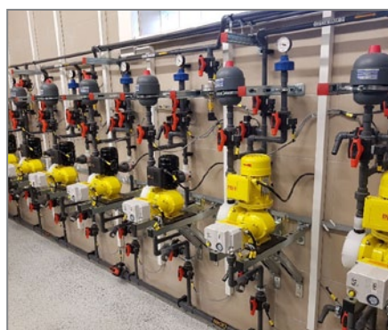
Fot. 6. System pompek dawkujących dezynfektant
