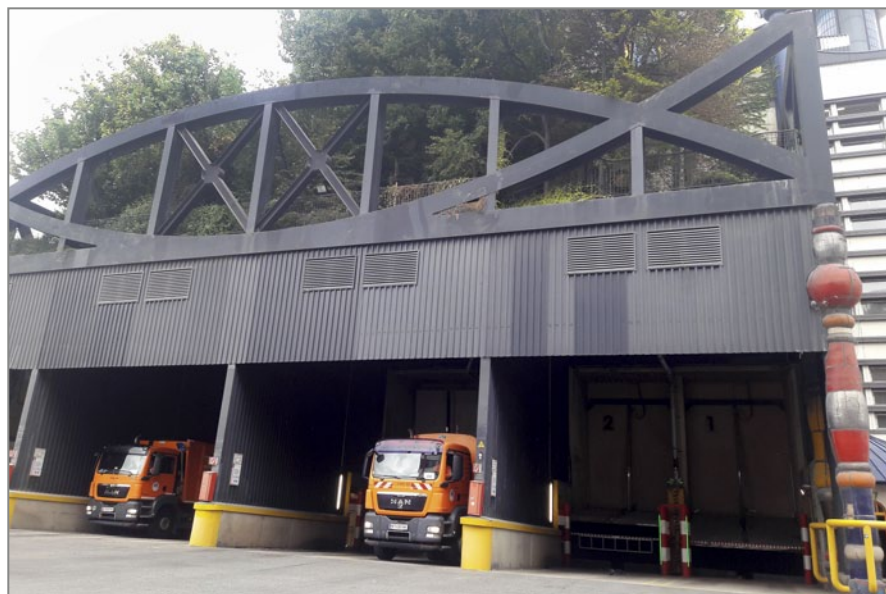
Zdj. 1. Stanowiska wyładownicze do bunkra odpadów w spalarni Spittelau.
