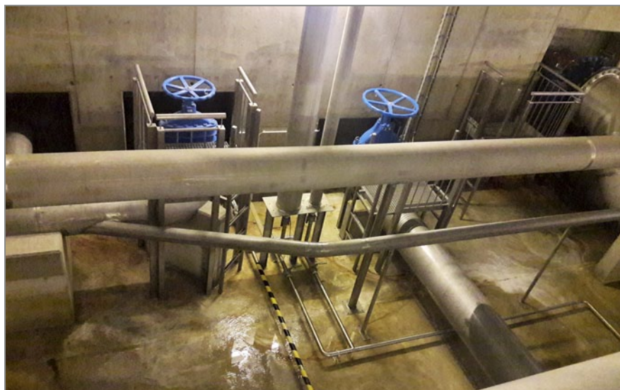
Zdj. 6. Komora zasuw w zbiorniku Wienerberg.
