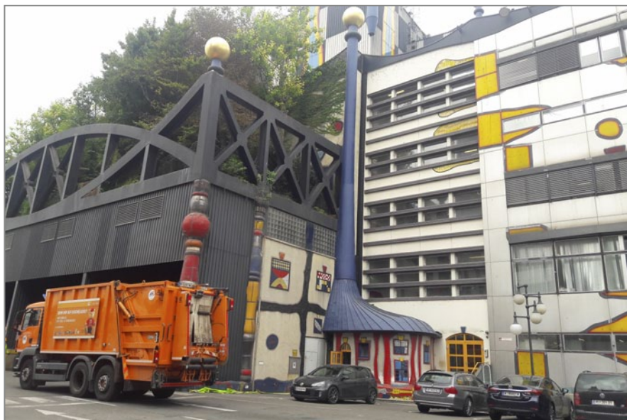
Zdj. 2. Budynek dyspozytorni, bunkier odpadów i wc dla kierowców samochodów śmieciarek.
