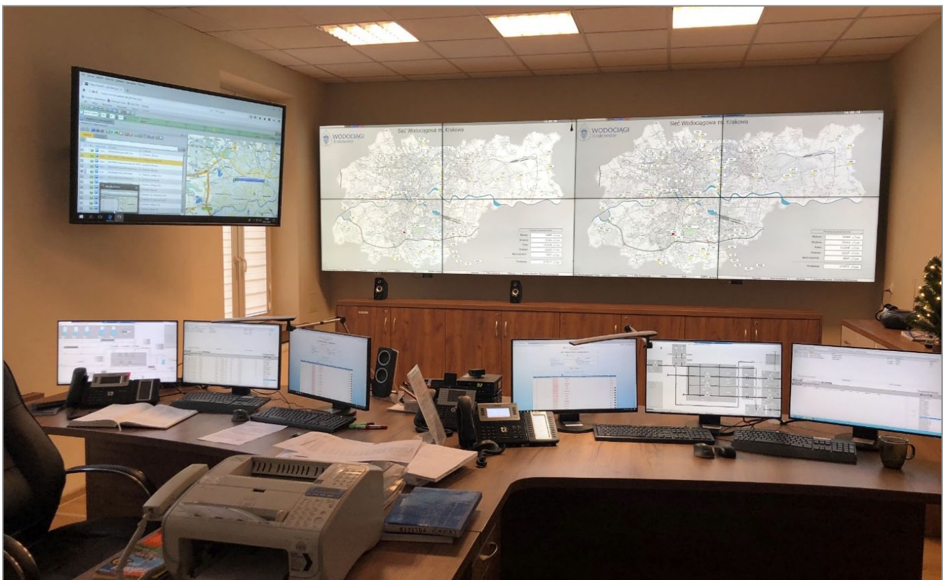
Fot. Centralna Dyspozytornia Wodociągów Miasta Krakowa
