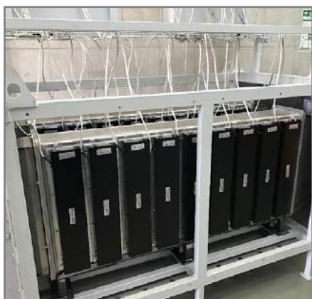
Fot. Widok wnętrza generatora termoelektrycznego.
