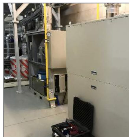
Fot. Widok turbin biogazowych w trakcie prac montażowych.
