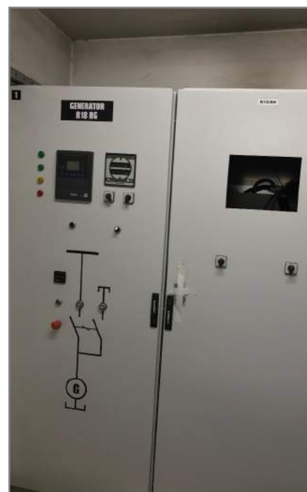
Fot. Szafa przyłączeniowo sterownicza generatora w trakcie prac montażowych.
