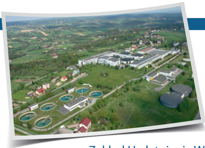
Zakład Uzdatniania Wody RABA
