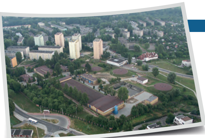
Zakład Uzdatniania Wody DŁUBNIA
