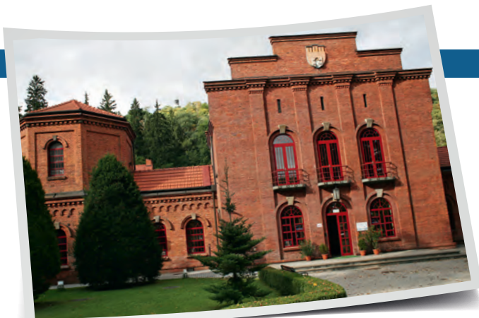
Zakład Uzdatniania Wody BIELANY
