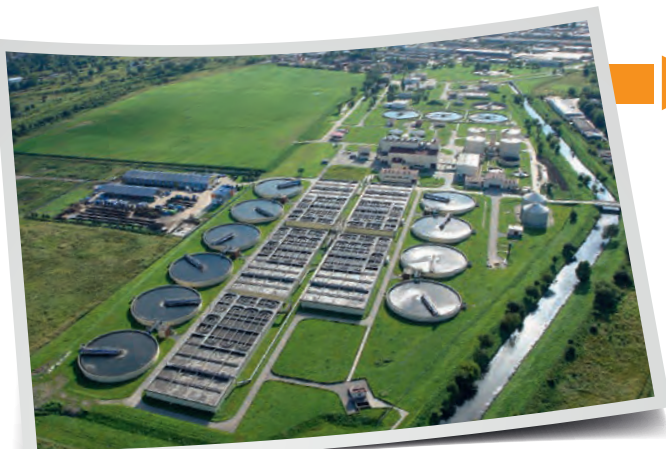
Oczyszczalnia Ścieków PŁASZÓW
