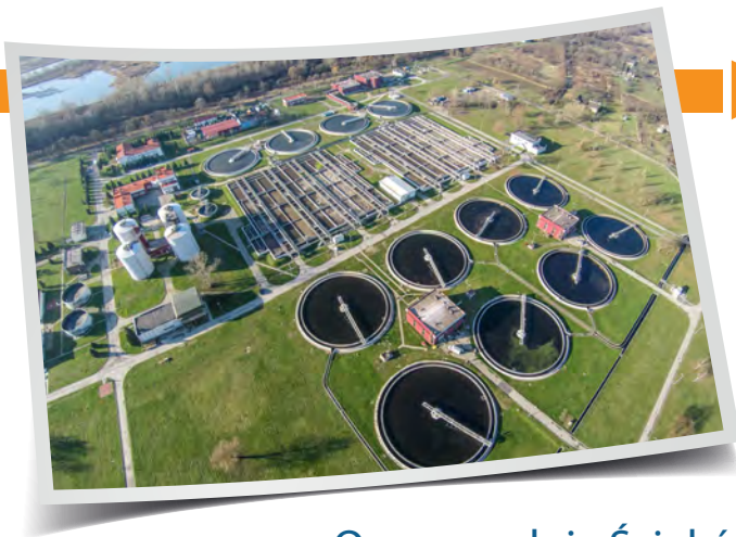
Oczyszczalnia Ścieków KUJAWY
