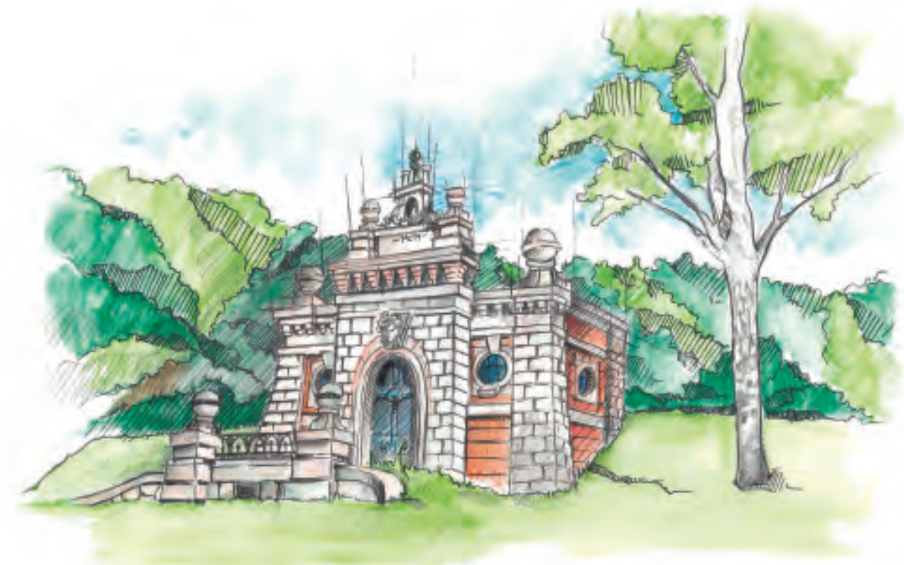
Zbiornik wody pitnej Kościuszko
