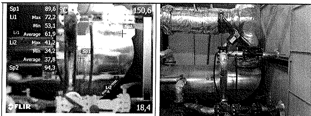
Rysunek 3.15 Wymiennik W 2 silnika JK1.
