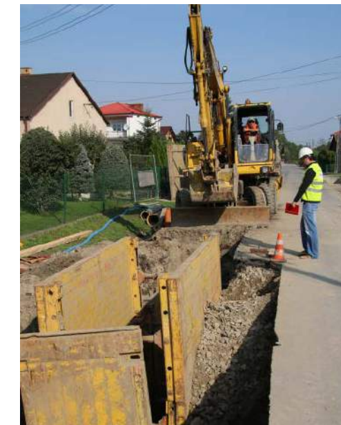
Prace ul. Wyciąska
