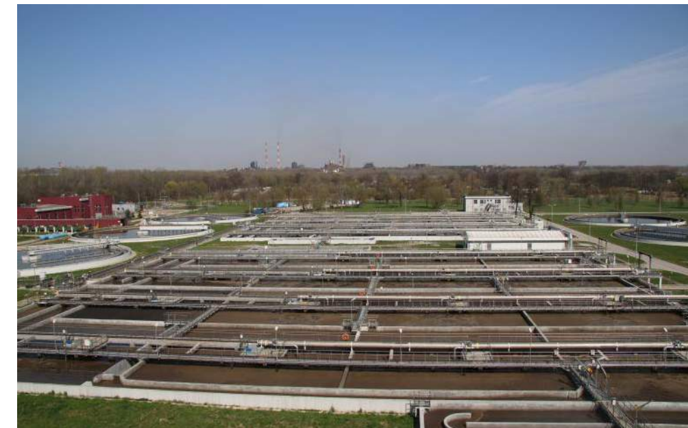
Komory osadu czynnego
