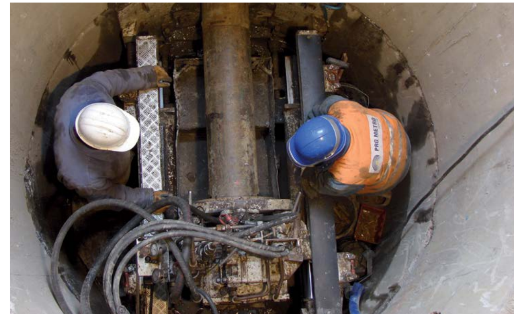
Przewiert ze studni S4 do S3 w ul. Obozowej w Krakowie
