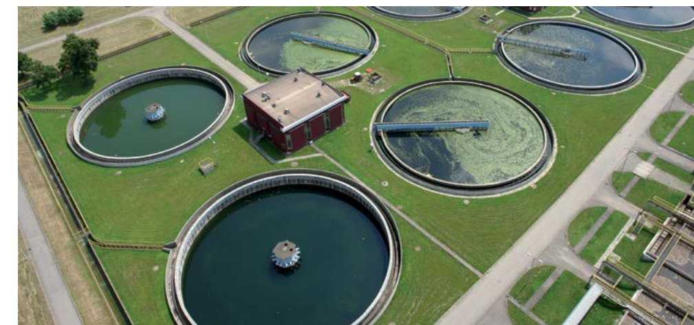
Osadniki wtórne – Oczyszczalnia Ścieków „Kujawy”
