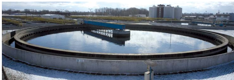
Osadnik wstępny – Oczyszczalnia Ścieków „Kujawy”
