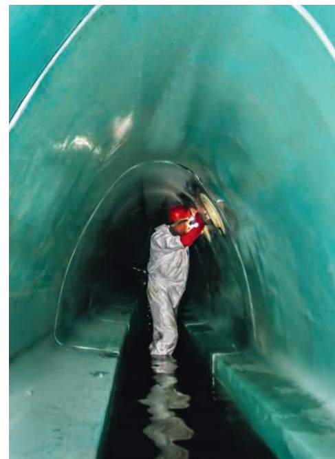
Wnętrze odnawianego kolektora
