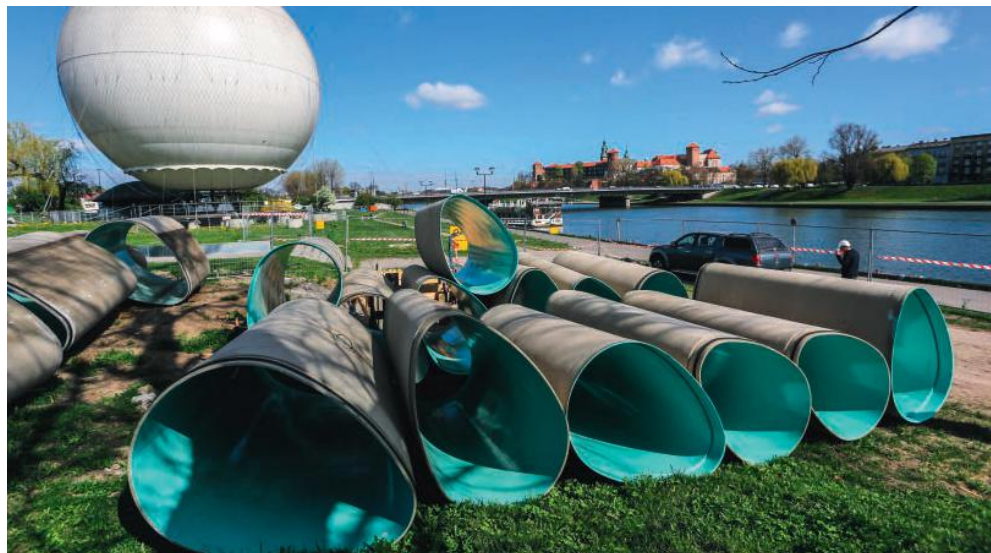
Panele CRP użyte do renowacji
