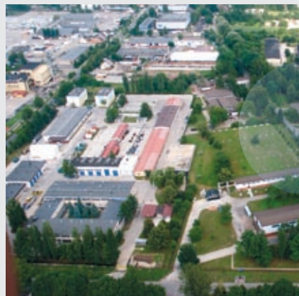
Zakład Uzdatniania Wody „Rudawa” data uruchomienia: wrzesień 1955 r. wydajność: 55 tys. m 3 /dobę
