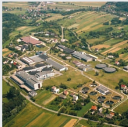
Zakład Uzdatniania Wody „Raba” data uruchomienia: wrzesień 1974 r. wydajność: 186 tys. m 3 /dobę
