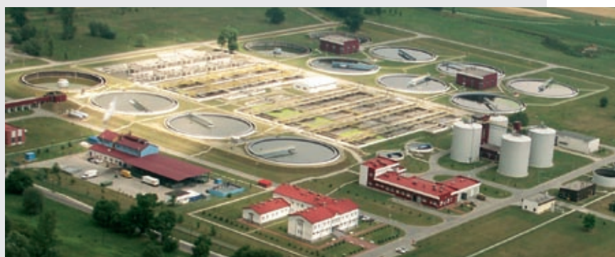
Zakład Oczyszczania Ścieków Kujawy data uruchomienia: maj 1999 r., wydajność: 80 tys. m 3 /dobę
