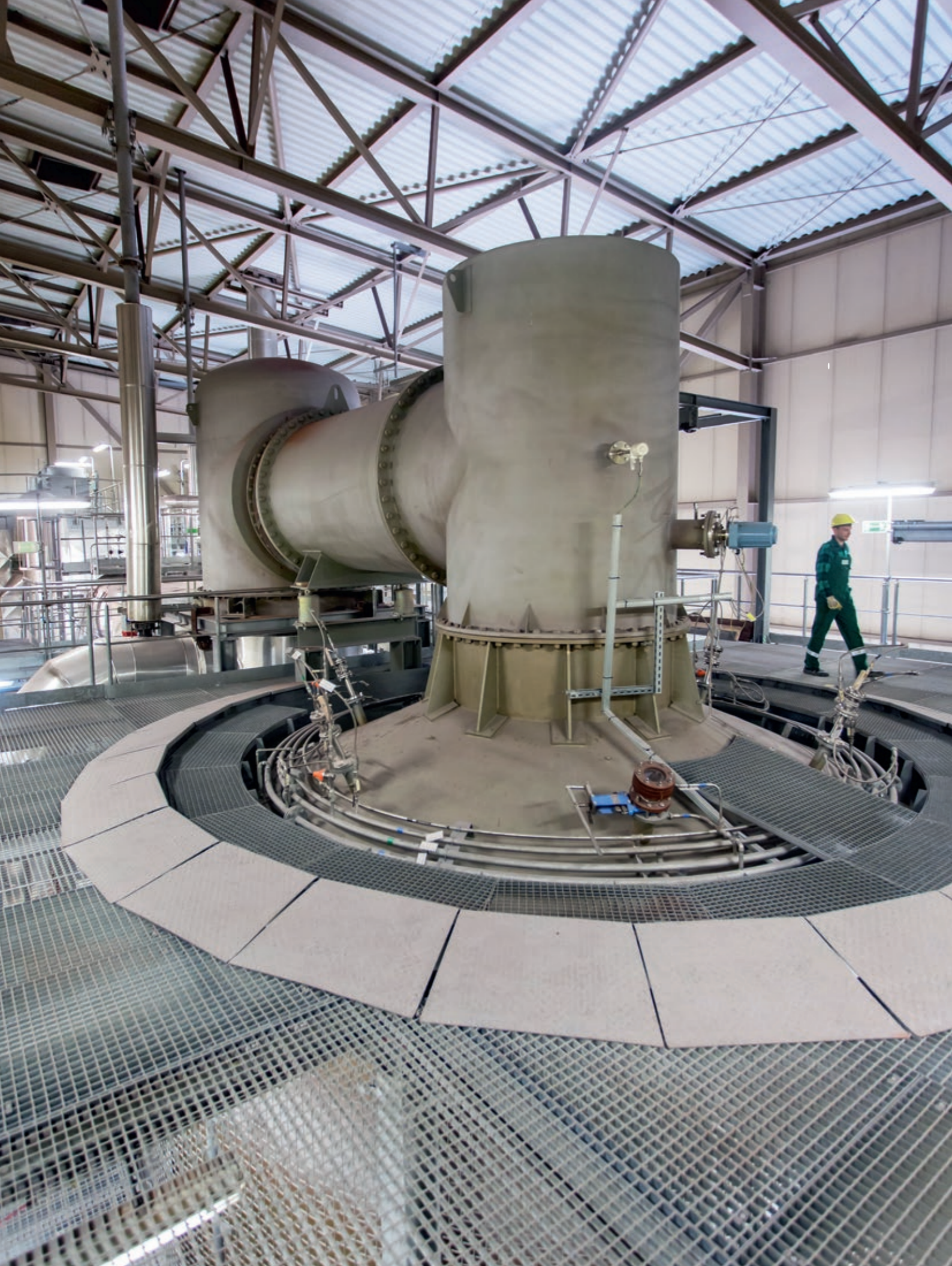
▲ Kopuła pieca wraz z kanałem wylotowym spalin – Stacja Termicznej Utylizacji Osadów
