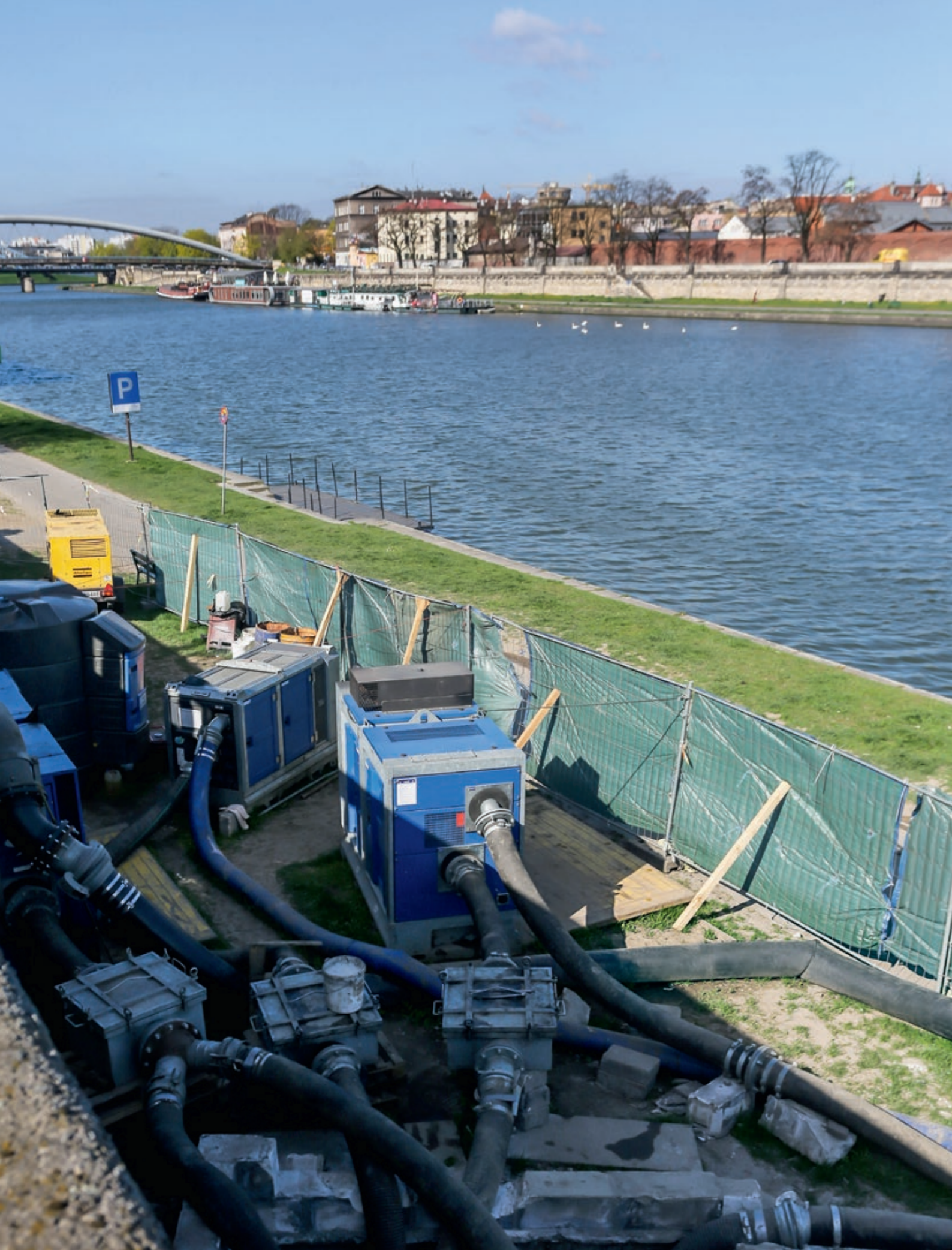
▲ Zestaw pomp do przetłaczania ścieków – modernizacja kolektora od ul. Rollego do ul. Stoczniewców w ramach projektu unijnego „Gospodarka wodno-ściekowa w Krakowie – Etap III”
