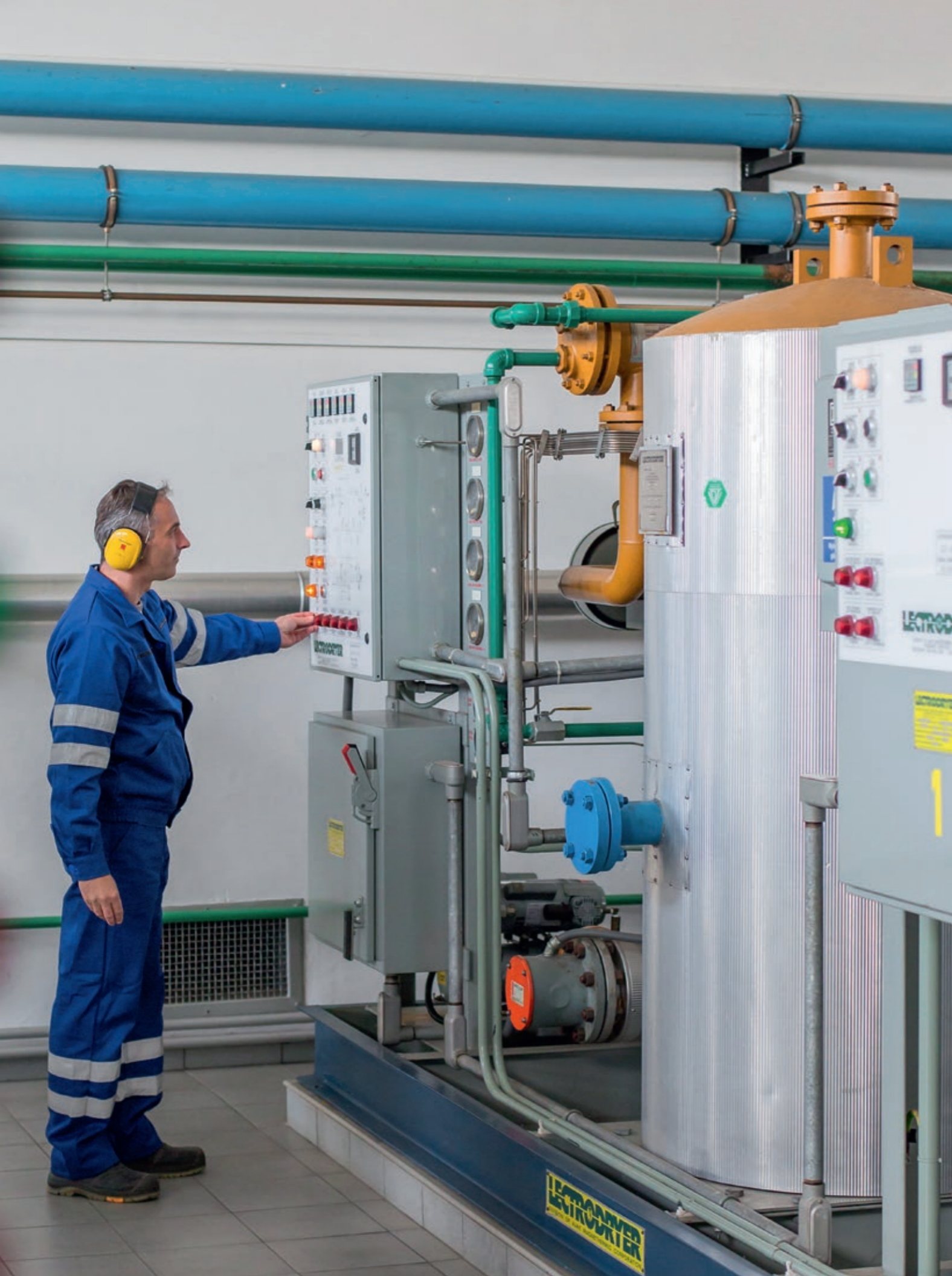
▲ Instalacja ozonu – Zakład Uzdadniania Wody Raba
