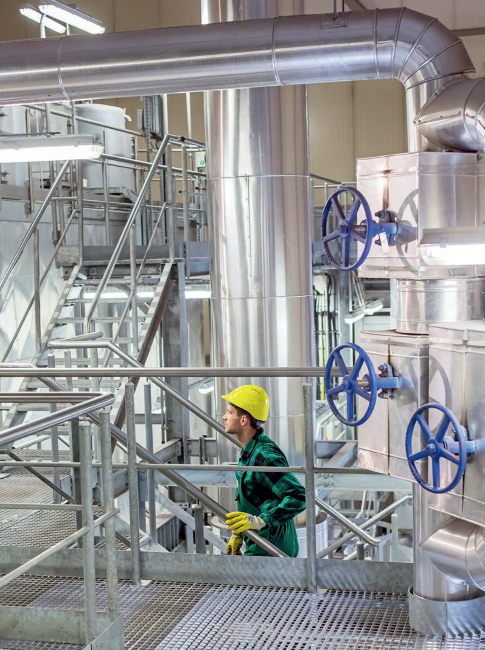
▲ Rurociągi pary technologicznej – Stacja Termicznej Utylizacji Osadów
