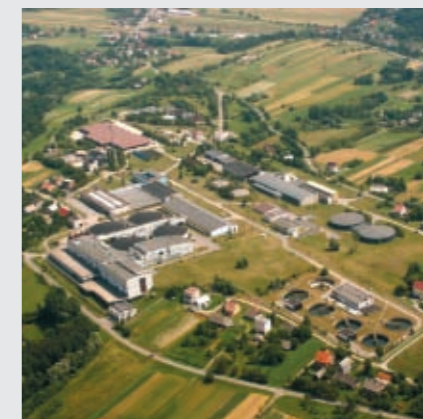
Zakład Uzdadniania Wody „Raba” data uruchomienia: wrzesień 1974 r. wydajność: 186 tys. m 3 /dobę
