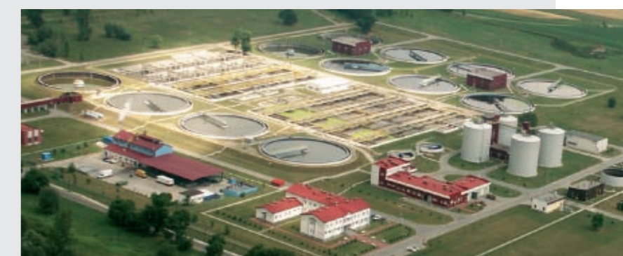
Zakład Oczyszczania Ścieków Kujawy data uruchomienia: maj 1999 r., wydajność: 80 tys. m 3 /dobę
