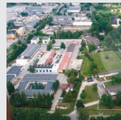
Zakład Uzdadniania Wody „Rudawa” data uruchomienia: wrzesień 1955 r. wydajność: 55 tys. m 3 /dobę
