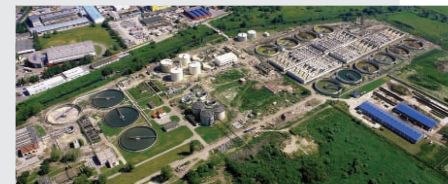
Zakład Oczyszczania Ścieków Płaszów I – data uruchomienia: 1976 r., Zakład Oczyszczania Ścieków Płaszów II – data uruchomienia: październik 2007 r., wydajność: ciąg mechaniczny 656 tys. m 3 /dobę, część biologiczna: 320 tys. m 3 /dobę
