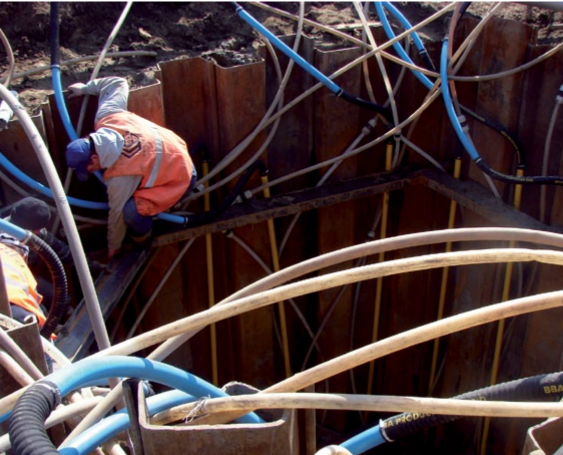
Budowa systemu kanalizacji sanitarnej we wschodnich rejonach miasta Krakowa (Dzielnica Nowa Huta)
