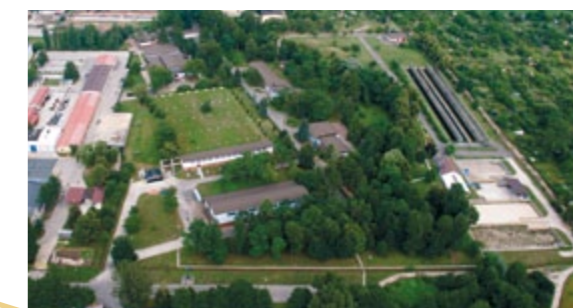
Zakład Uzdatniania Wody „Rudawa” data uruchomienia: wrzesień 1955 r. wydajność: 55 tys. m 3 /dobę
