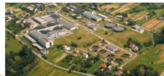
Zakład Uzdatniania Wody „Raba” data uruchomienia: wrzesień 1974 r. wydajność: 186 tys. m 3 /dobę
