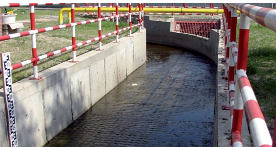
Uporządkowanie kanalizacji w rejonie Borku Fałęckiego poprzez odłączenie potoku Urwisko
