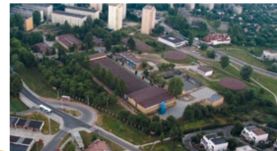
Zakład Uzdatniania Wody „Dłubnia” data uruchomienia: styczeń 1960 r. wydajność: 25 tys. m 3 /dobę
