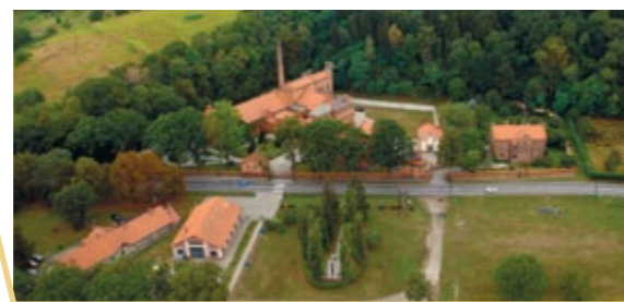
Zakład Uzdatniania Wody „Bielany” data uruchomienia: luty 1901 r. wydajność: 25 tys. m 3 /dobę
