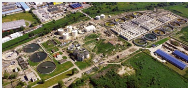
Zakład Oczyszczania Ścieków Płaszów I – data uruchomienia: 1976 r., Zakład Oczyszczania Ścieków Płaszów II – data uruchomienia: październik 2007 r., wydajność: ciąg mechaniczny 656 tys. m 3 /dobę, część biologiczna: 320 tys. m 3 /dobę
