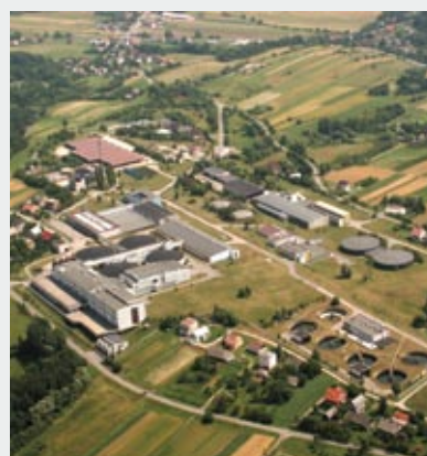
Zakład Uzdatniania Wody „Raba” data uruchomienia: wrzesień 1974 r. wydajność: 186 tys. m 3 /dobę
