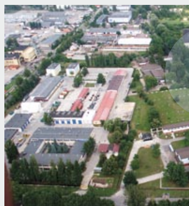
Zakład Uzdatniania Wody „Rudawa” data uruchomienia: wrzesień 1955 r. wydajność: 55 tys. m 3 /dobę
