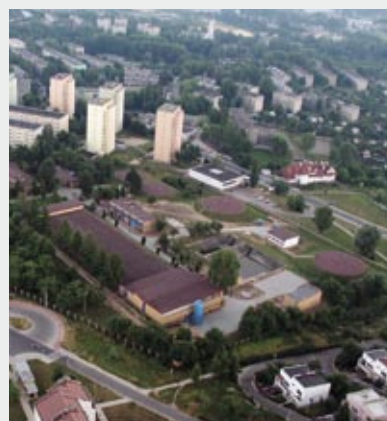
Zakład Uzdatniania Wody „Dłubnia” data uruchomienia: styczeń 1960 r. wydajność: 25 tys. m 3 /dobę
