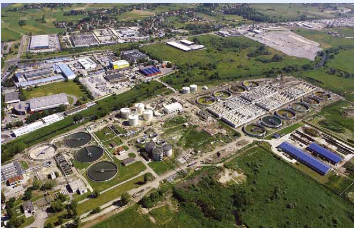
Zakład Oczyszczania Ścieków Płaszów II
