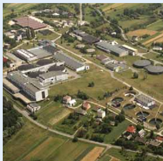
Zakład Uzdatniania Wody Raba
