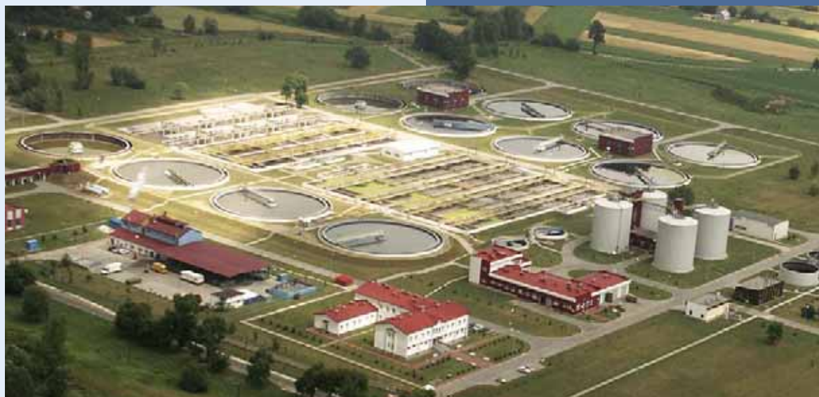
Zakład Oczyszczania Ścieków Kujawy
